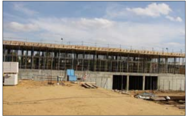
Aspecto que presentan las obras.
