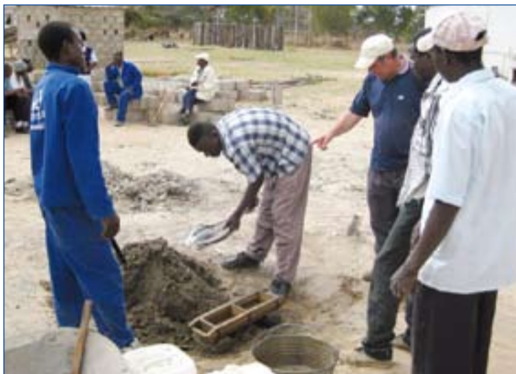
Construcción de un dormitorio en Dandanda, Zimbabue.
